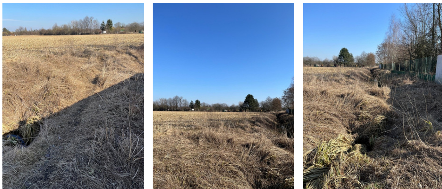
Zdjęcia z wizji terenowej, przedstawiające przepust nad rowem Brx-14 i jego koryto. (źródło fotografii: ZZM)
